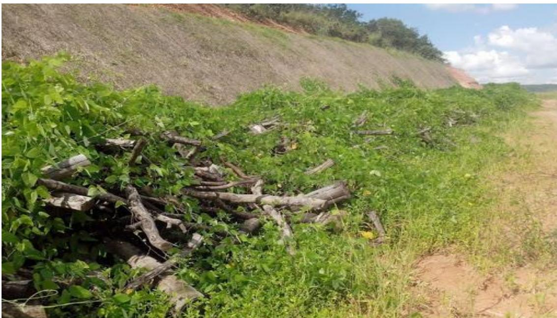
Figura 03 A galharia colocada na encosta da base da erosão associada ao plantio de grama
