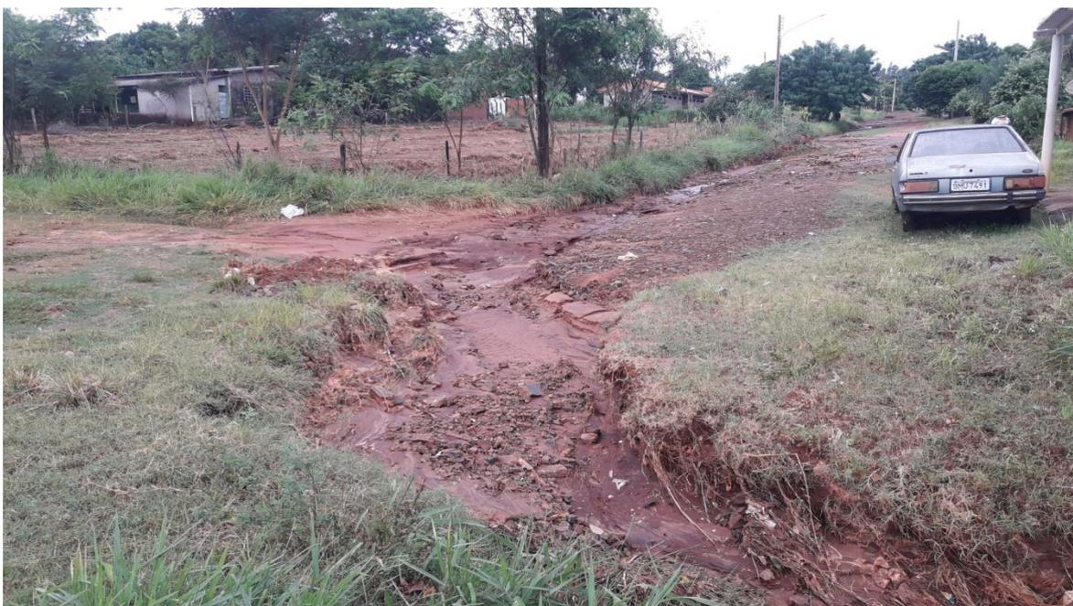
Foto 01 mostra o ponto em que as águas pluviais saem da via pública em direção a propriedade privada.
